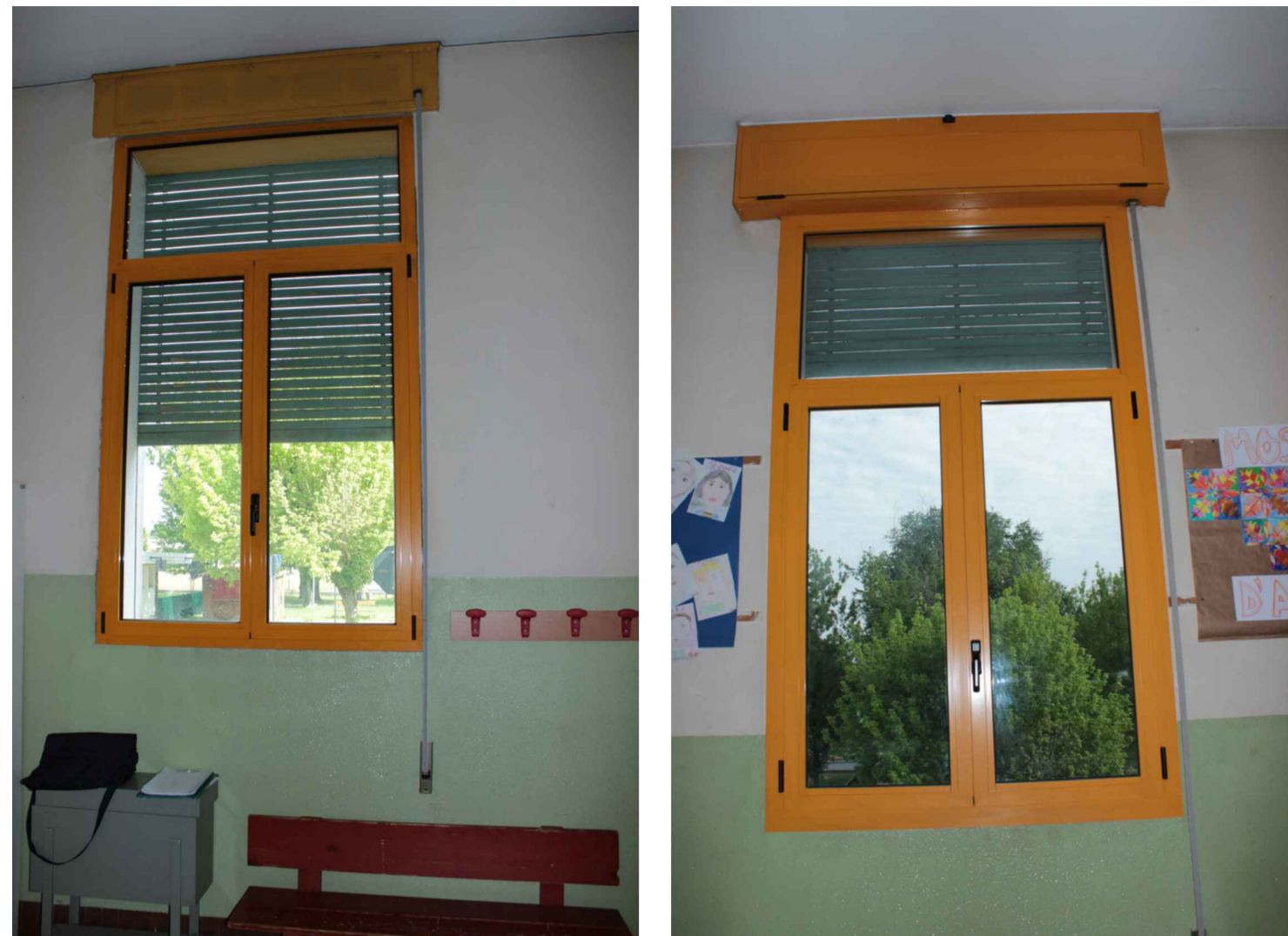
FOTO SERRAMENTI ESISTENTI DA SOSTITUIRE CON NUOVI DI TIPO A
